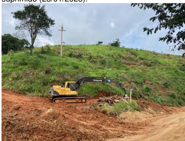
Foto 3 –Atividade de remoção do material arbóreo suprimido (07/02/2023).
