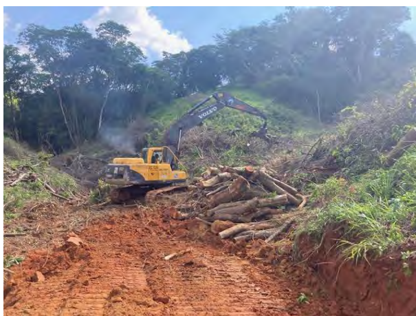
Foto 1 –Atividade de remoção do material arbóreo suprimido (25/01/2023).
