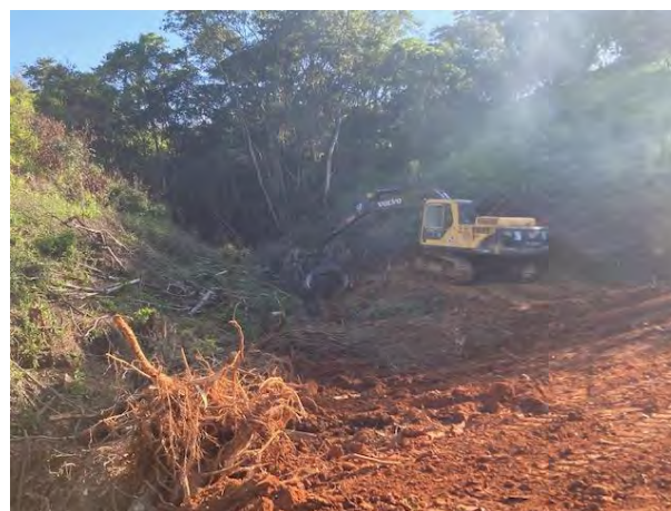
Foto 2 – Atividade de remoção do material arbóreo suprimido (25/01/2023).
